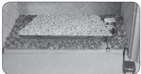
Fig. 12-4 Place vermiculite granules
